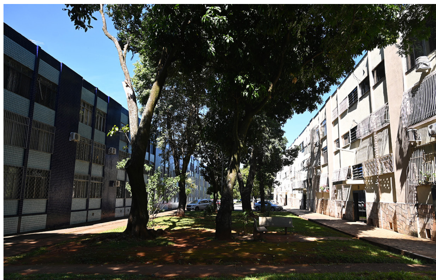
FIGURA 8 –Edifícios residenciais das fileiras “400”.
